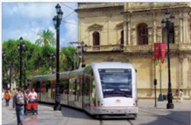
Sevilla: Nahe der Kathedrale wurden die sehr massiven und optisch störenden Fahrleitungs masten wieder abgebaut. Die Fahrleitung wurde alternativ an den vorhandenen Laternen ver-spannt, was diese allerdings mit »Schleiflaggen« quilltieren T. KRÖGER/EPFLA
